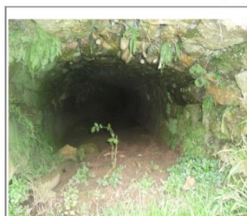
Sortie du tunnel d'écoulement de l'eau du moulin
