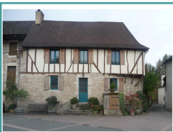
Maison du XVII ème avec rez-de-chaussée en pierre et étage en torchis
