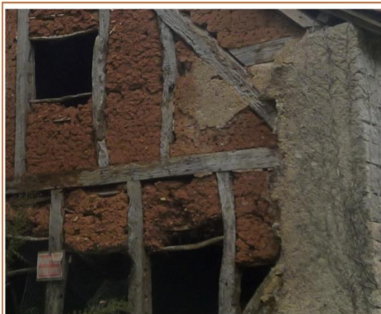
Vue d'un mur avec torchis et colombages
